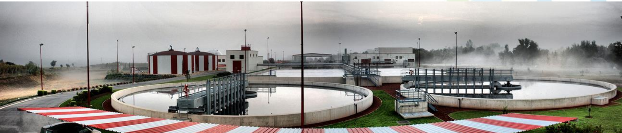
El Cidacos WWTP, Calahorra, Spain
